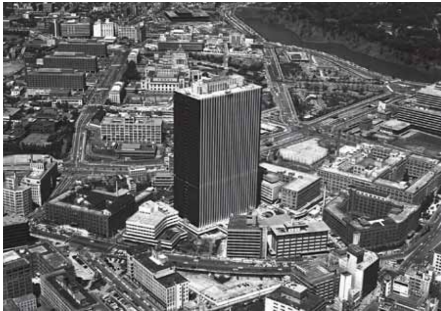
竣工直前の全景【所蔵：三井不動産】 日本初の超高層ビルのデザインとして、“大地のスピリットが集まってだんだん天に昇っていくイメージ”を描いていた。当初から外装は“縦縞(たてしげ)”のデザインを目指し、柱型を強調する意匠を追求していた【解説：上口泰位】
