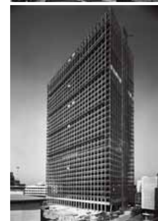
上一層の梁型の孔型を持つH型鋼・ハニカムビーム：梁材を軽量化するため、H型鋼のウェブをジグザグに切断し、その山型の個所を溶接して組み合わせた“ハニカムビーム”が考案された。肉抜きとしての孔口は設備ダクト貫通、配電配管に利用されている | 中一鉄骨組み上げ風景：串型に3層分の2段梁を工場溶接してプレハブ化し、スパン中央部で現場溶接することで、建方ビームの減少と接合部の簡易化を図った | 下一鉄骨建方完了時の全景(1967年3月)：柱断面の補強を目的とした2段梁は、建物の周期調整と耐震性能の向上、市販サイズのH型鋼の活用などのメリットを生んだ【解説：上口泰位 | 所蔵3点とも：三井不動産】
