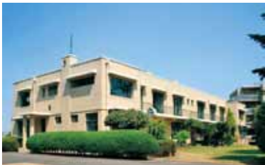
ライジングサン石油会社社宅フラット(現・フェリス女学院山手10号館) [1929]
