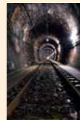
中央本線・大日影トンネル [撮影：西山芳一]
