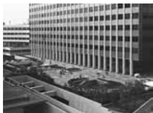
竣工当時の広場：特定街区によって整備され、日本初の公開空地となった【所蔵：三井不動産】
