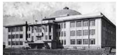
星商業学校(現・星薬科大学本館)[1924] レーモンドが設計した東京における最初のRC造。ファサードはライト調、窓面にはチェコ・キュビズムの表現を取り入れ、講堂上部にドームを持つ。左右対称の平面、入り口の庇の大谷石など、ライトの影響が色濃く残っている[出典：「自伝アントニン・レーモンド」]
