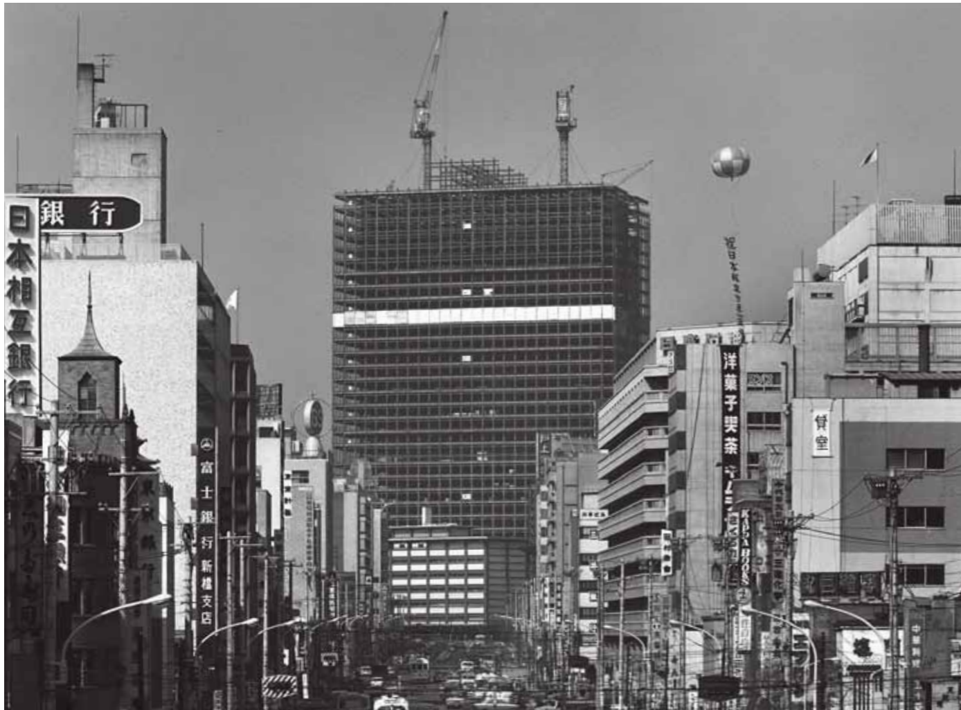
新橋方面から見た建方完了直前の全景【所蔵：三井不動産】 「鉄骨の全ぼうが見えてくると、それが実に美しい。東京のスカイラインに強烈なアクセントを生みだした」と武藤清氏は『鹿島建設月報』1968年5月号に記している。外装デザインが決定したのは、この写真が撮影された約1か月後の1967年3月末。38,000m 2 のカーテンウォールを、当時の最速取り付け事例の3倍以上の早さで、4か月の短期間のうちに完了している【解説：上口泰位】
