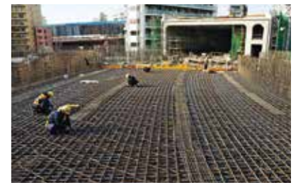
施工中。編み物のように組まれた鉄筋 [写真：八馬 智]
