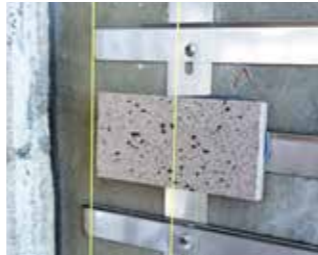
ステンレス金物を併用したタイル取付け
