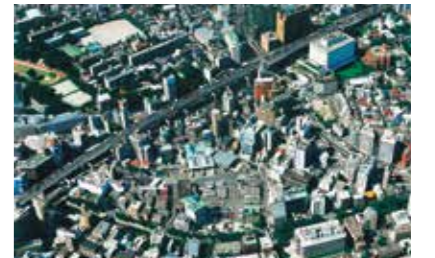
着工前の大橋地区の様子（1997年6月30日撮影） [提供：首都高速道路]
