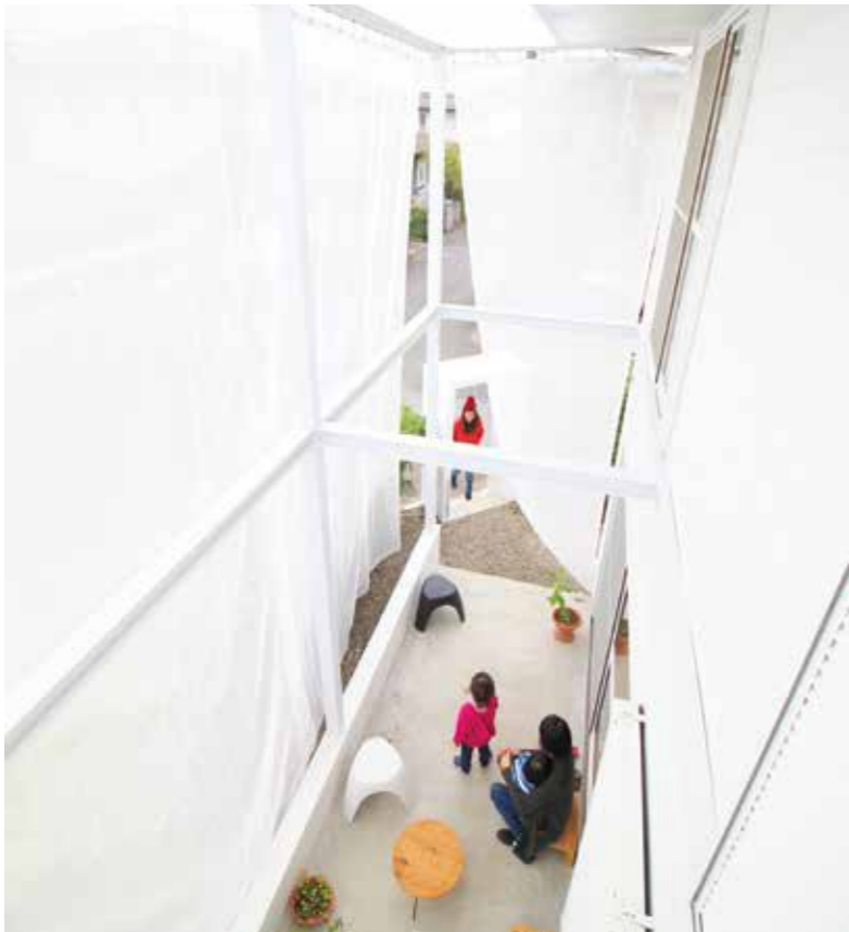
上 | 新宿の小さな家 (2011) 東京の住宅密集地に建つ夫婦と生まれたばかりの子どものための小さな住宅。小さな敷地で広がりのある空間を確保するために、地面から屋根までつながる3層分の大きな吹き抜けを中心に諸室が配置されている。吹き抜けには梁が架けられ、子どもの成長に合わせて床を増やしていくことができる
