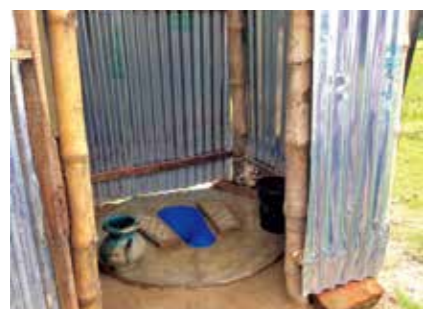
ウガンダの農村部でのSATO設置状態
