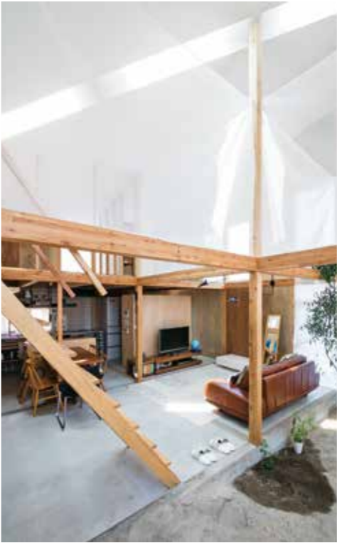
グリッド（2017）新興住宅地に建つ若い夫婦と子どものための住宅。敷地境界から45度振った2.73mグリッドの交点に、柱、植栽、ポスト、電柱など自然物と人工物が配置され、室内外をつなぐ。吹き抜けの玄関土間とリビングを中心に、寝室や水まわりが外周に配置される。スリット状のトブライトからの自然光は、柱間に張られた寒冷紗によって室内に拡散される
