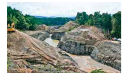
1次掘削後の分水路（2009年3月） 【提供：星野裕司（熊本大学くまもと水循環・減災研究教育センター准教授）】
