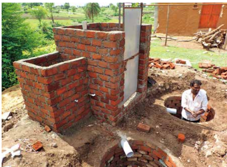
トイレ、2つのピットと手洗い場の施工の様子(インド)
