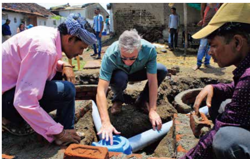
SATOの施工方法を現地の施工業者に丁寧に説明。インドでは2つのピット(排泄物を溜めておく槽)を準備し、いっぱいになったら切り替えて使用する
