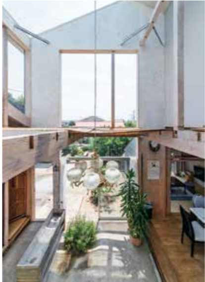
貝沢の家（2015）藤野氏が生まれ育った木造2階建ての実家の改修。もともと応接間だった中央の洋間の床壁天井を撤去し、外壁と屋根をガラスにすることで、明るい土間空間とした。古い材と新しい材、大工と建築家のディテールの境界を曖昧にして、現在と過去を溶かすようなリノベーションのあり方が模索された
