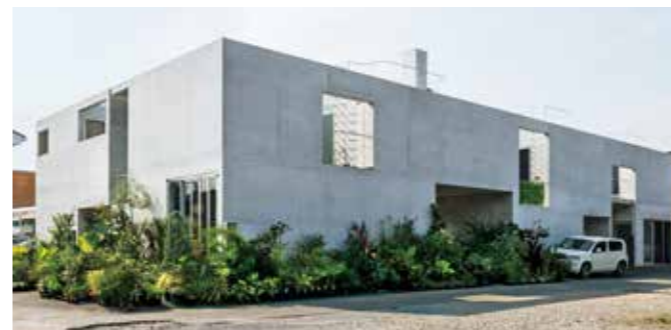
萩塚の長屋 (2011) 8世帯の賃貸集合住宅。壁式鉄筋コンクリート造で住戸はすべてメゾネット。地上から屋上まで、複数の外部空間が立体的に組み合わされている。外部空間は水道と電気を備えた世帯ごとの専用空間で、テラスやダイニング、ギャラリーなどに使われており、互いの生活の雰囲気を外観から感じることができる
