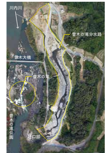
曾木の滝分水路位置図（2011年3月29日撮影） 【提供：国土交通省 九州地方整備局】
