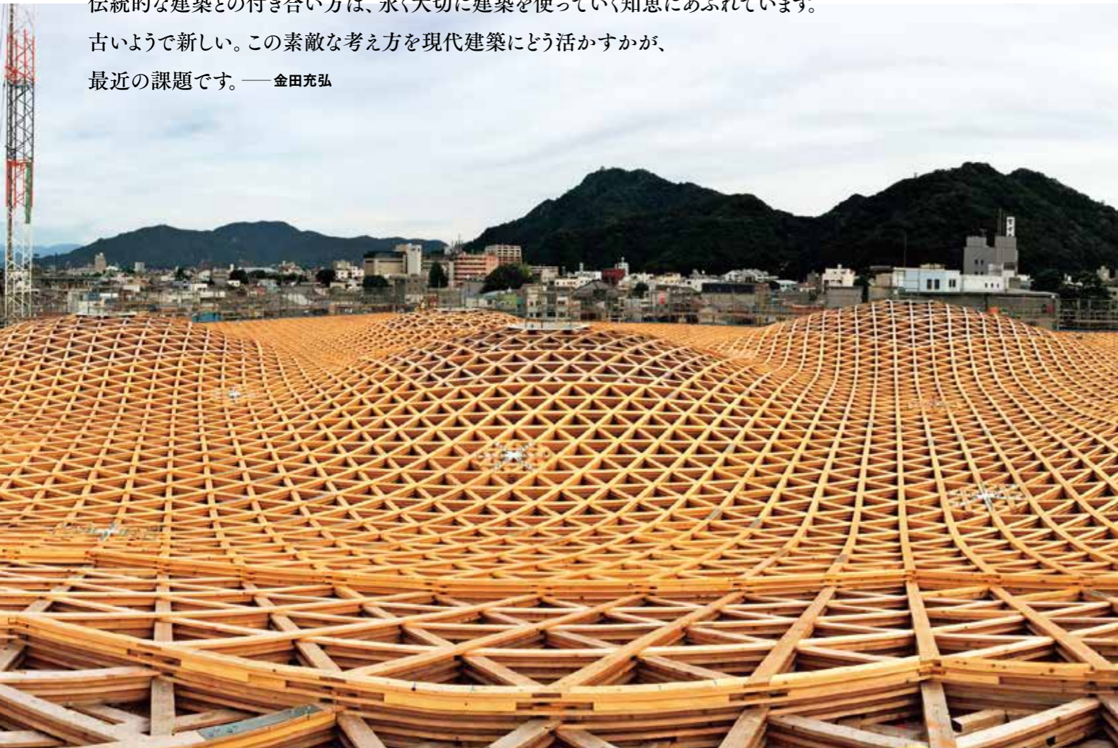
20×120×4,000mmのヒノキの汎用板材を12mまで工場でフィンガー・ジョイントしたあと、現場で三角格子に組み上げた屋根
