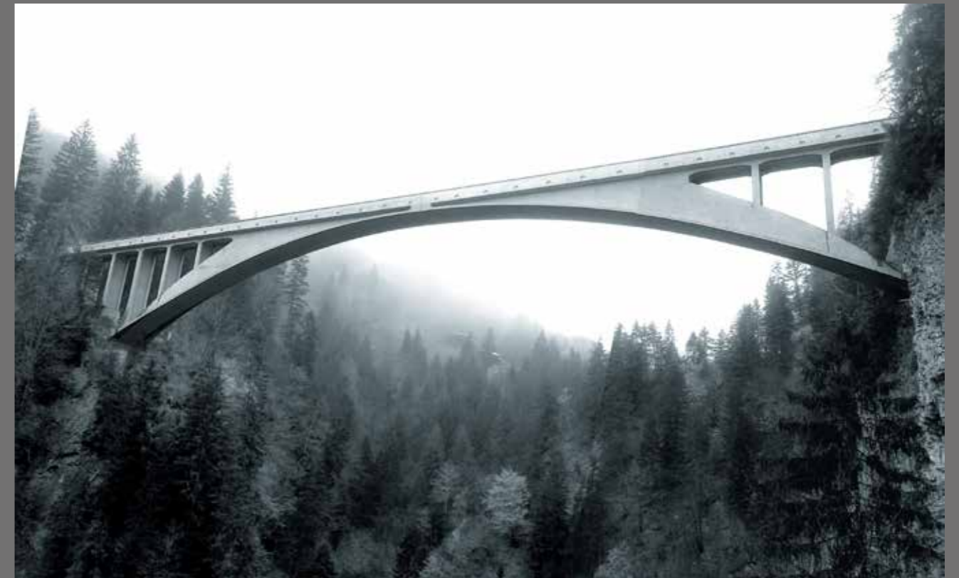
両端の橋脚の根元と、橋梁中央にヒンジをもつ3ヒンジアーチ構造 [写真: オノJAPAN]
