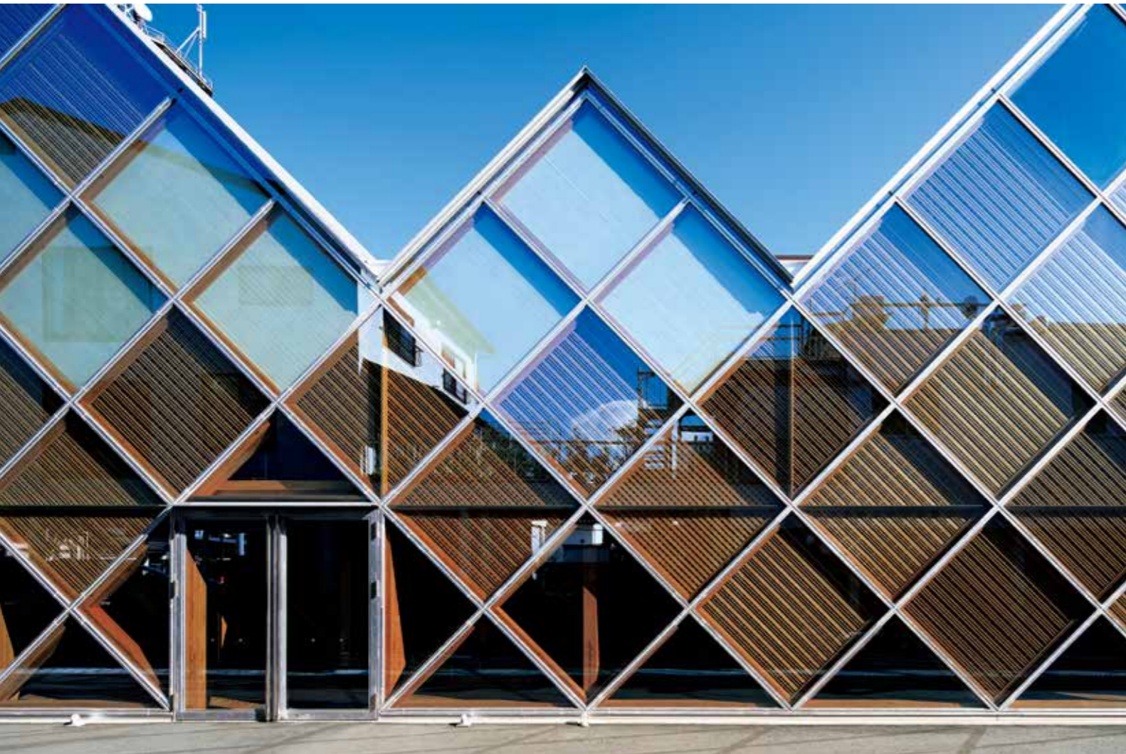
側面からの外観。斜め格子のアウトナーフレーム内部にインナーフレームが見える [写真：石田 篤]
