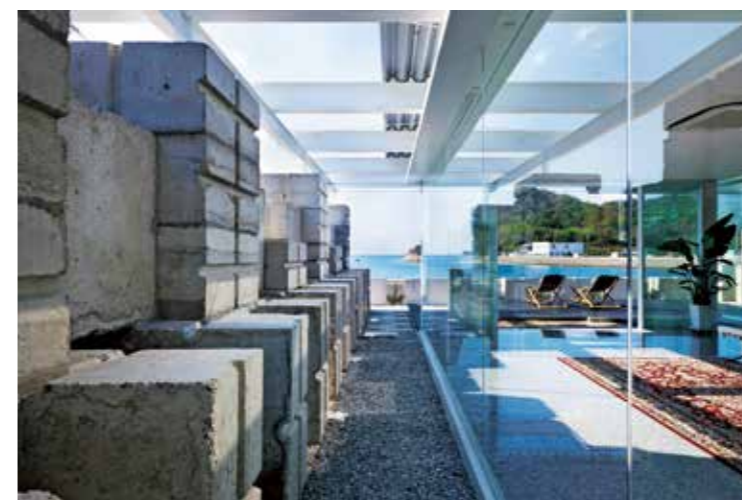
廃棄コンクリートブロックとガラス壁の間で大きなクリアランスをとっている【写真：矢野紀行】
