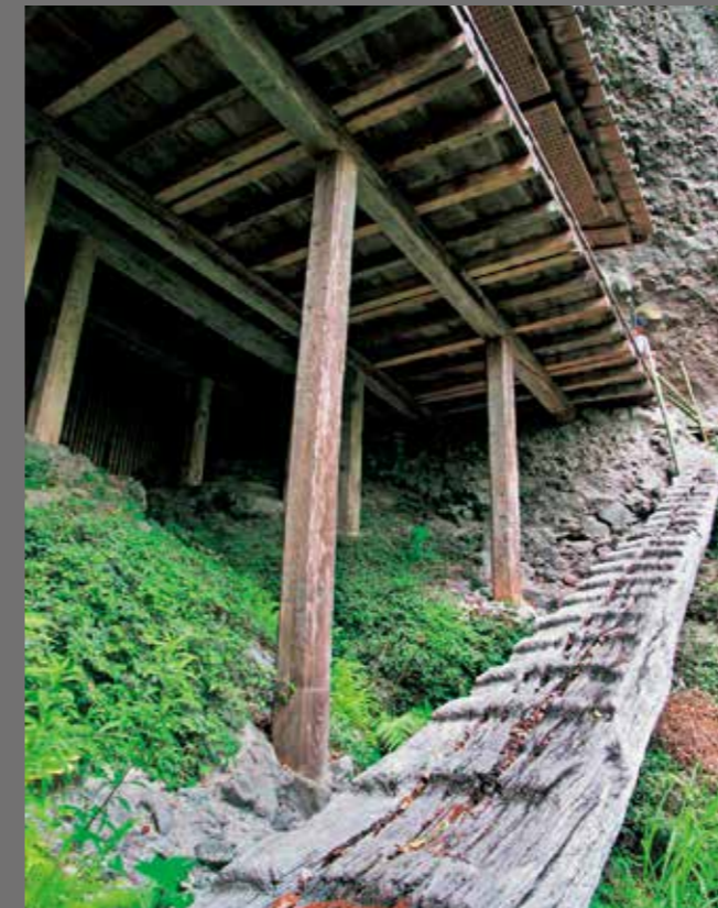
鎌倉時代の木造建築で、国の重要文化財。長い束柱が土台を支え、その上に根太が載る。各材は一定のピッチを刻みながら、それぞれはズレのある構成をとっている。束石の前に斜めに架けられているのは「きざし」(市指定有形文化財)。原始的作法のアプローチ階段で、伊勢神宮とここにしかない。現在は不使用 [写真: なわけんジム]
