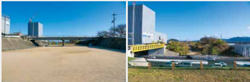
区間5「de愛ひろば」の東に位置する、未整備の区間6。旧草津川が流れていた当時は「草津川隧道(くさつがわすいどう)」が設けられ川の下を国道1号線が通っていたが、廃川後の2017年に隧道は撤去され橋が架けられた
