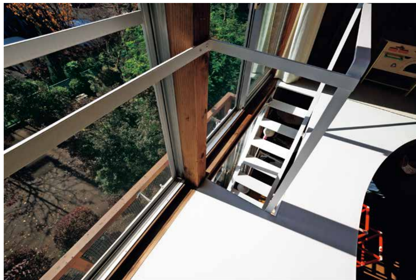
2階に新設した楕円天井上面。大開口に接して階段を設置。この階段のササrahがプレースの役割を果たす
