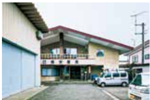
20 | 大館木材会館 (現・保安産業社屋)
