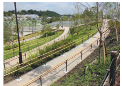
公園など広範囲に及ぶ場合は、全体の構図を見せつつ緑を取り入れることも重要です。
