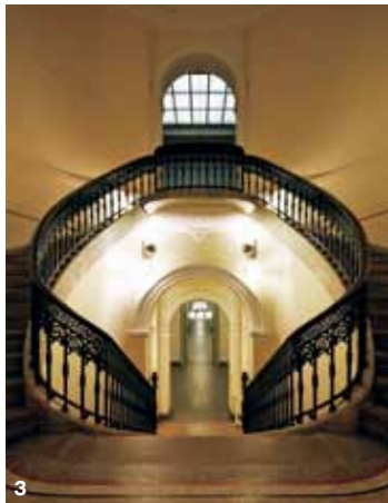
1 2階回廊 中央ドームを8本の大理石のイオニア式円柱が支えている。柱の台座と手すりも大理石で、品のあふれる落ち着いた空間となっている 2 1階中央ホールからのドーム見上げ 8本の円柱があたかもドームの中心に向かうような奥行き感を出し、2階回廊の明かりも夜空のような神秘性を醸し出している 3 階段室 円塔の階段室の踊り場から1階の展示室を見る。明かりのコントラストにより引き立つ錬鉄製手すりの曲線が秀麗 4 正面外観 中央大ドーム、両端小ドームの緑青銅板が青空に映える壮麗なネオ・バロック様式。1階のトスカナ式角柱、2階のイオニア式円柱が力強い。建物を守護する正面玄関脇の2頭の青銅製ライオンは大熊氏広の製作による
